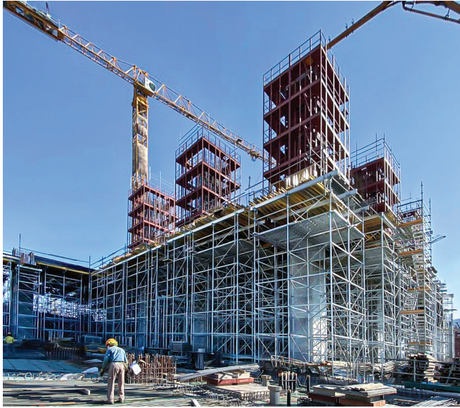
香港國際機場 青鵝高端物流中心
